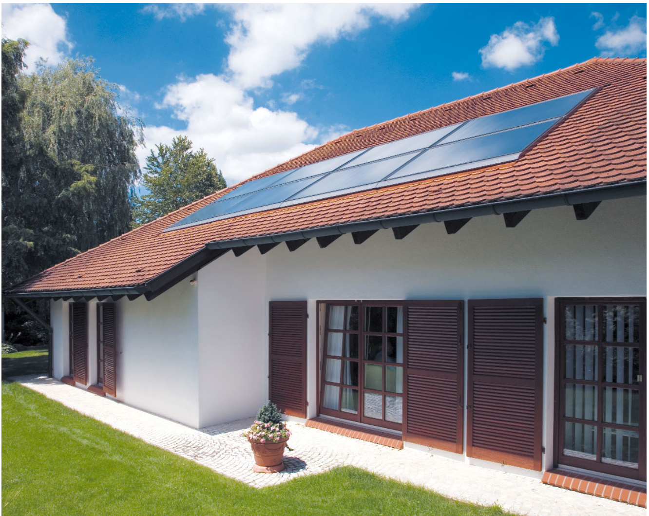
8-płytowe pole kolektorów w układzie poziomym zamontowane w dachu
