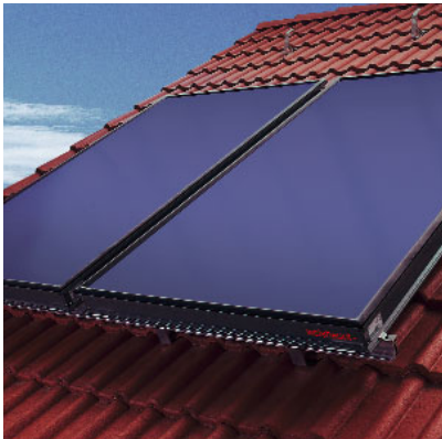
Kolektory zamontowane na dachu
